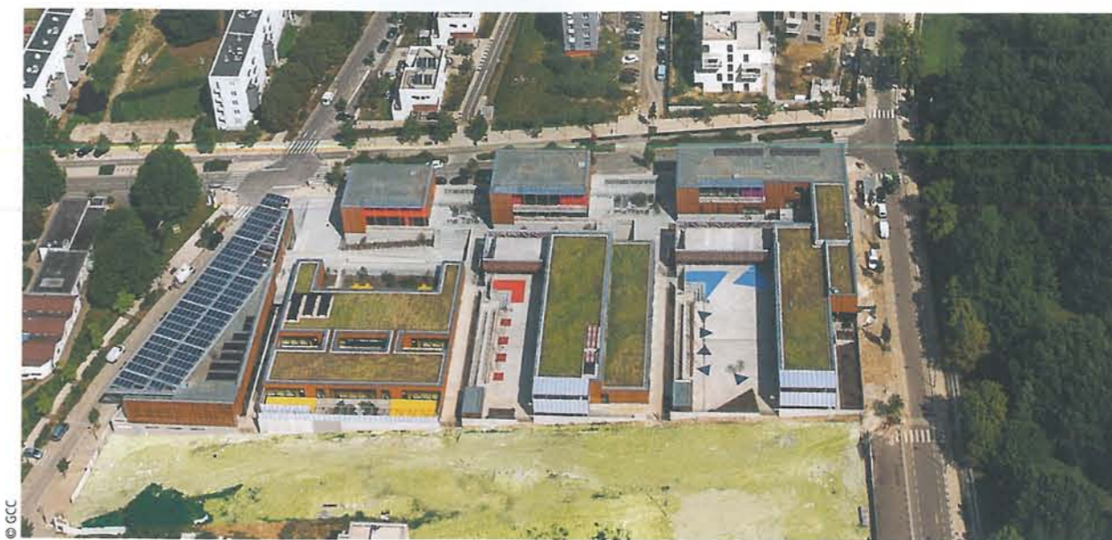
^ Au premier plan, le futur parc Molière encore en chantier.
